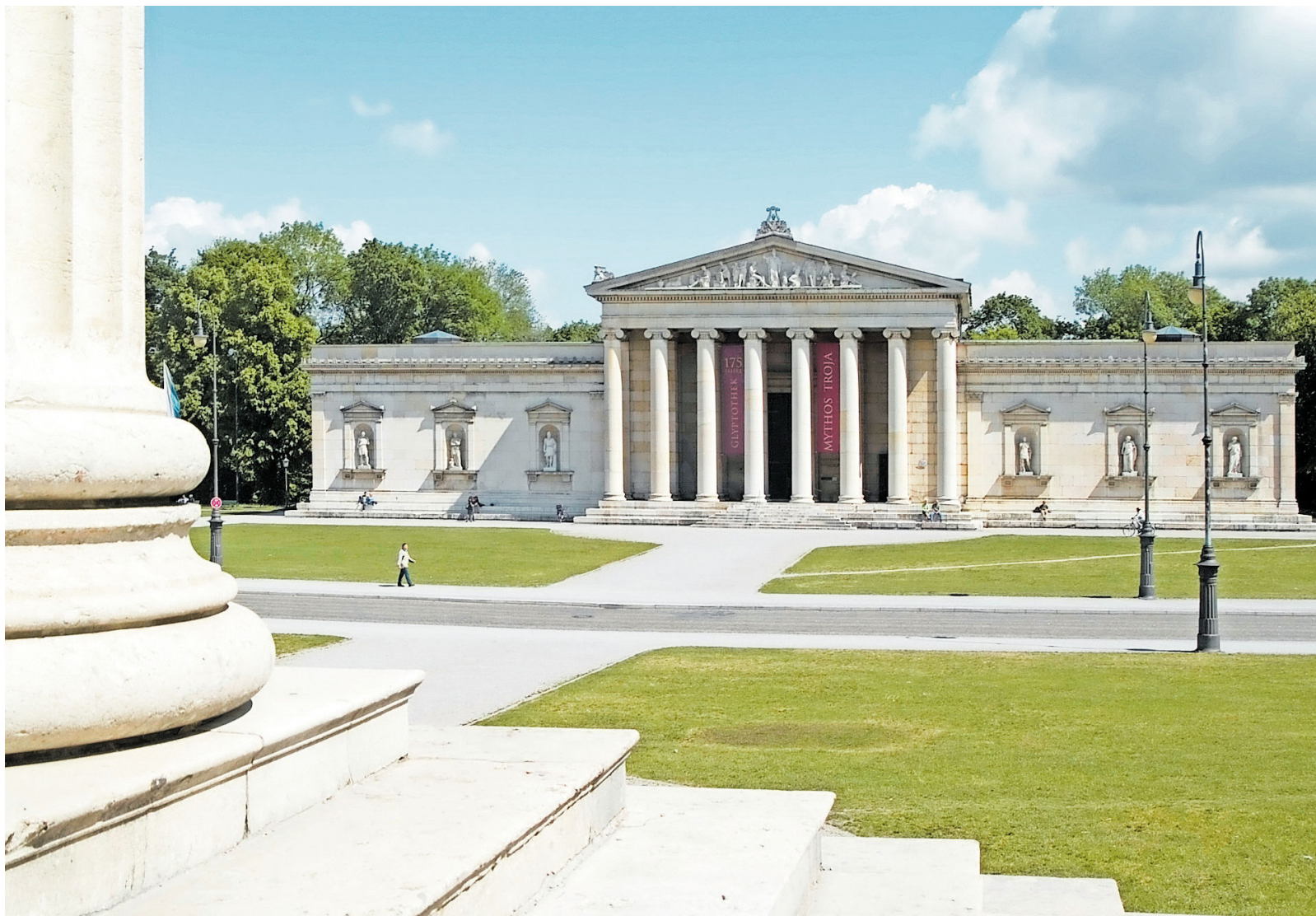
So schön oder noch viel schöner soll sich die Glyptothek am Königsplatz präsentieren, wenn sie im November wiedereröffnet wird. Im Moment ist das Haus jedoch noch mit Staubschutzmatten umhüllt und von einem Bauzaun umgeben.
